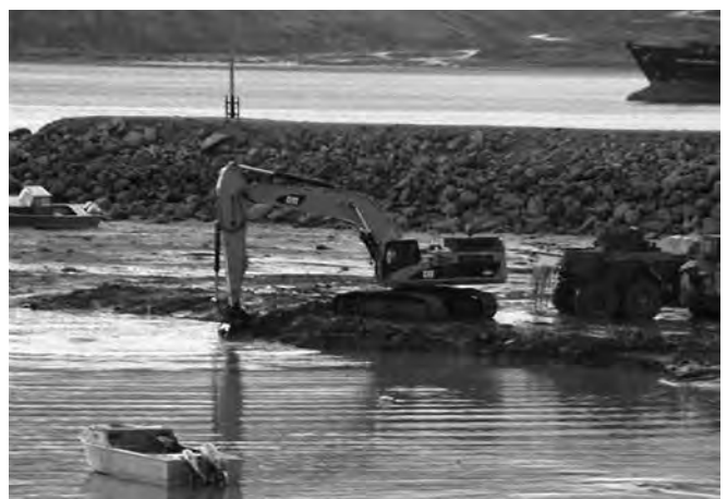
Pangnirtung, Nunavut - La construction d'un port pour petits bateaux est en cours. Photographie gracieusement offerte par la municipalité de Pangnirtung.
