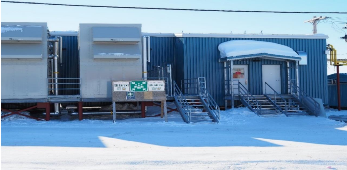
Nouvelle centrale électrique de Pangnirtung
