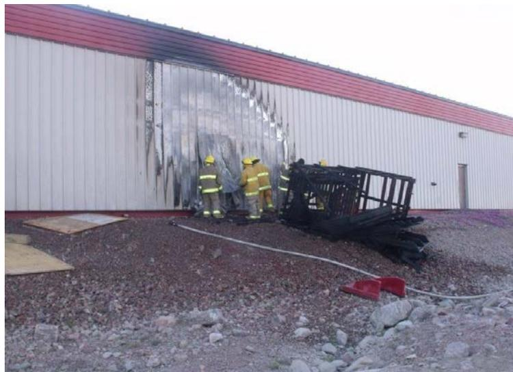
L'incendie d'une palette vide a endommagé un bâtiment commercial. L'incident aurait pu être évité par une mise au rebut adéquate de la palette.
