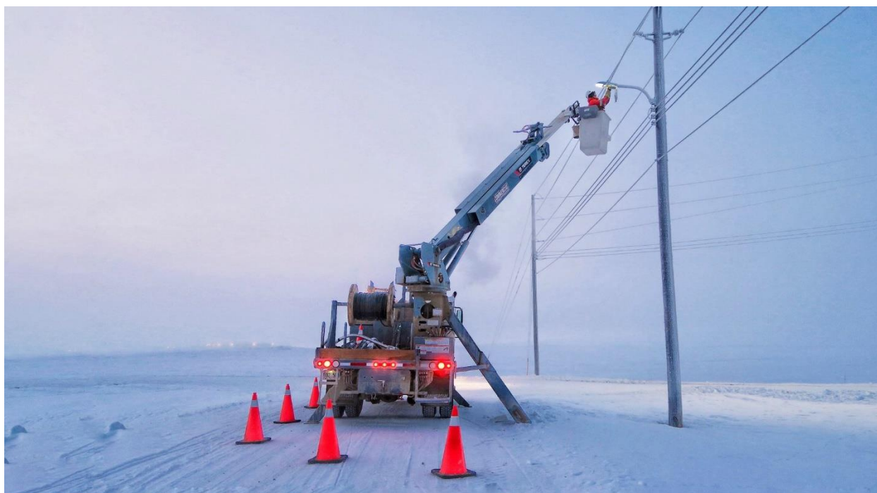
Installation de lampadaires à DEL
