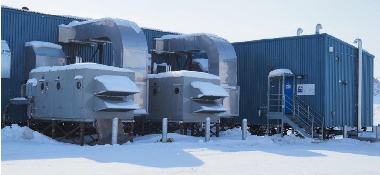
Centrale électrique de Qikiqtarjuaq
