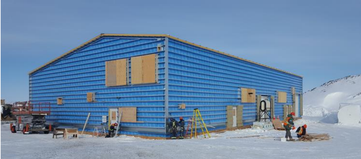
Construction de la centrale électrique à Cape Dorset
